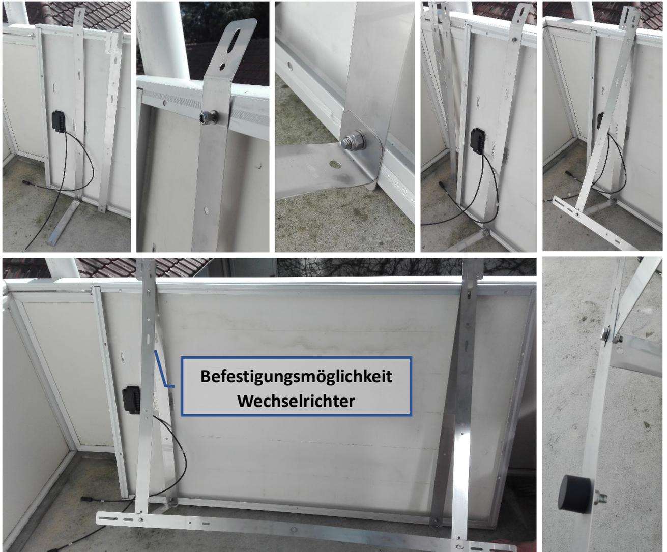
Abbildung 4: Bild 1 - Teile für ein Dreieck und das Modul; Bild 2 Modulhalterung oben mit 20° - Biegung; Bild 3 - Distanzstrebe mit 110° - Biegung; Bild 4 – Modulhalterung und Distanzstrebe verschraubt; Bild 5 Aufhängung und Verbindungsstrebe sind montiert; Bild 6 – Fertig montierte 20° - Halterung (ohne Wechselrichter); Bild 7 – montierter Gummipuffer an der Verbindungsstrebe.
